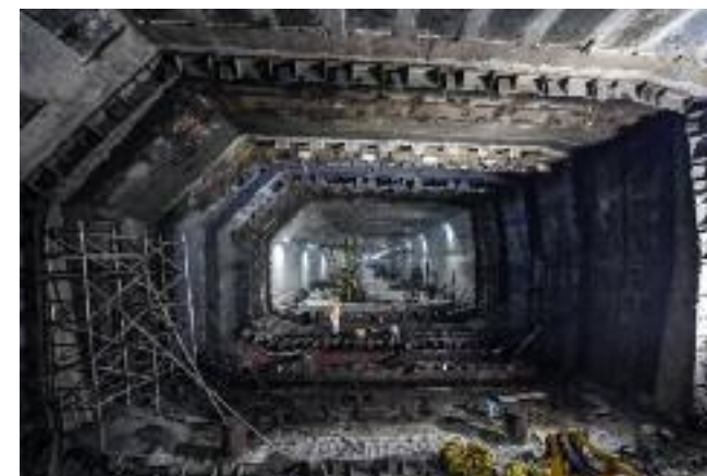
Operai edili al lavoro per completare gli ultimi punti di giunzione all'interno del tunnel. 工人正在吊装港珠澳大桥沉管隧道的最终接头。
